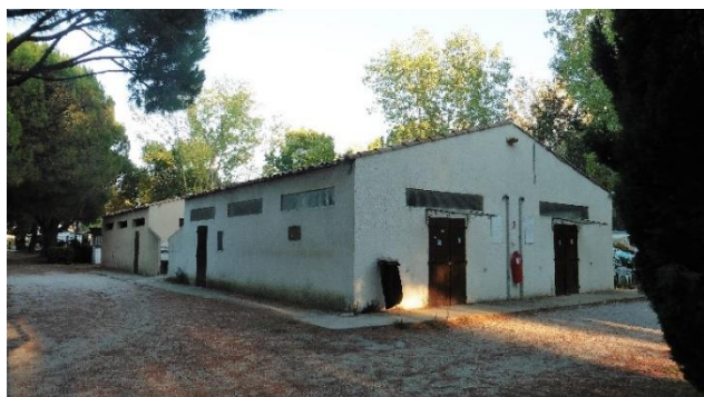
L'area dei bagni e lavatoi completamente in disuso e vandalizzata ...
